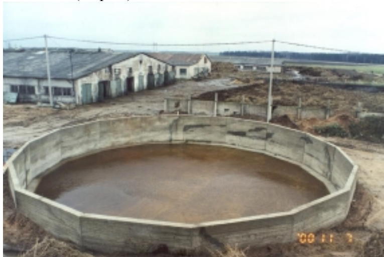
20 pav. Bariūnų ŽŪB karvidės srutų talpykla
